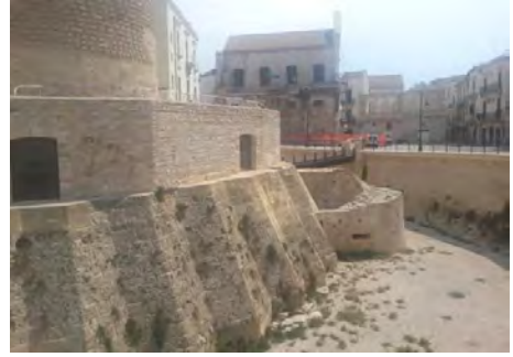
Fig. 3- Bitonto, torrione, Particolare dell'antemurale ziggagato e i resti di uno sprone casamattato a mandorla.
