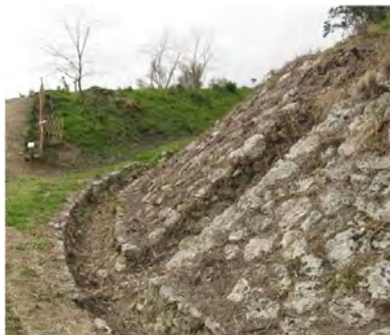
Figura 4- Cunetta di raccolta. Forte S. Jachiddu, Messina.
