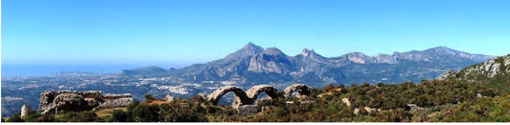
Fig. 2-Vista desde Bernia hacia el sur con los restos de la fortaleza proyectada por J.B. Antonelli en primer plano. Al fondo, la ensenada de Benidorm y la sierra de Aitana (B. Marco, 2011).
