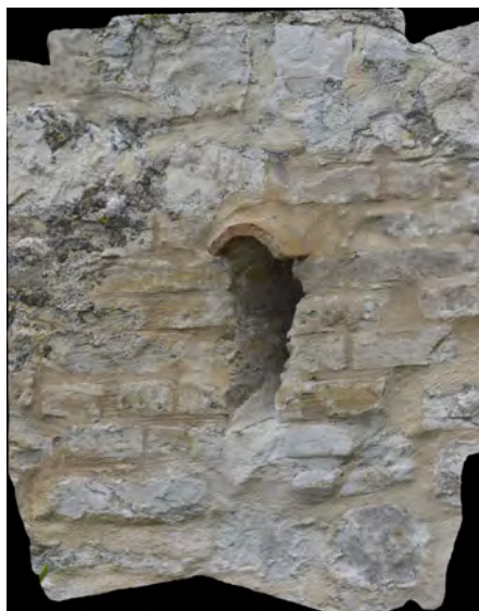
Fig. 9- Ricostruzione di una feritoia del prospetto Est con l'uso del software Agisoft Photoscan (F.Giansanti, P.Formaglini, S.Giraudeau, 2016).
