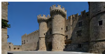
Fig. 2- L'ingresso principale al Palazzo del Gran Maestro.
