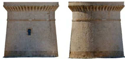
Fig. 11- Alzados fotogramétricos de la torre (TOVIVA Project, 2016).
