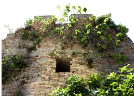
Fig. 4- Torre Mucchia. Prospetto S: dettagli.
