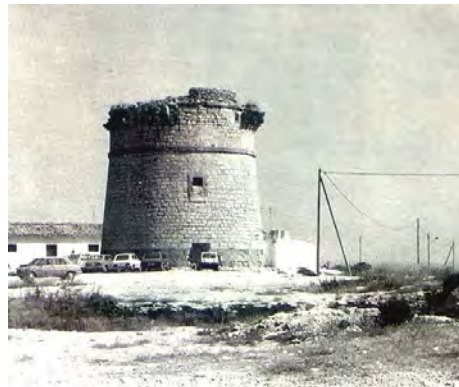
Fig. 2- Fachada noroeste de la torre, antes de su restauración. (Fotografía histórica).
