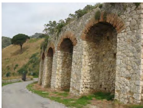
Figura 9- Contenimento della strada militare del Forte S. Jachiddu, Messina.
