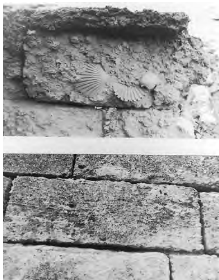
Fig. 5- Carlentini (SR). Particolare delle mura in due diversi tratti dove sono impiegati biolititi e di calciruditi per produrre tipologie simili di conci ben squadri.
