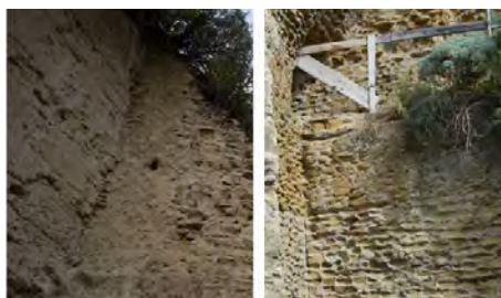
Fig. 11 a-b - Tracce di opus reticulatum sui lati della torre; b Muratura mista.
