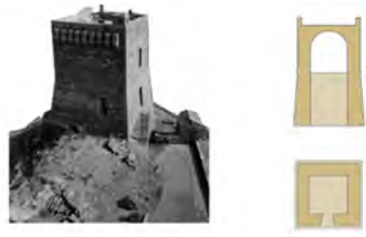
Fig. 9a- Tower of the Giraglia, 1571, Capo Corso.
