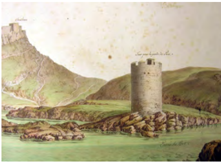
Figg. 2-3- Il centro fortificato e la torre di Castelsardo in Sardegna SHD/M, 98, cc. 48 e 49 (Jacques Pétré, 1679).
