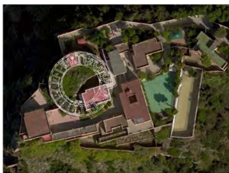
Fig. 5– Rilievo del 1890 sovrapposto ai resti del torrione (foto aerea, Google Earth, 2016).
